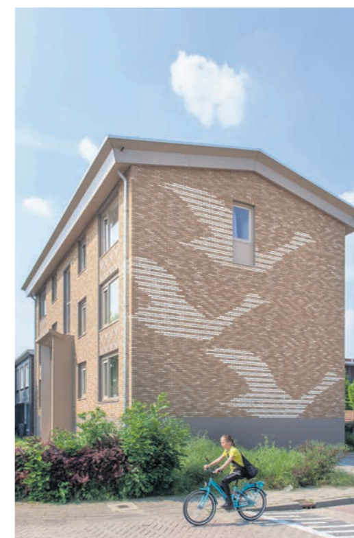
De portiekwoningen aan de Laurentiusstraat in Huissen hebben een complete facelift gehad van Waardwonen. De buitenkant heeft een totaal andere uitstraling gekregen. Dat komt doordat de flats aan de buitenkant zijn geïsoleerd en er vervolgens een nieuwe buitenmuur is gebouwd. Ook de vloeren en daken zijn geïsoleerd.
