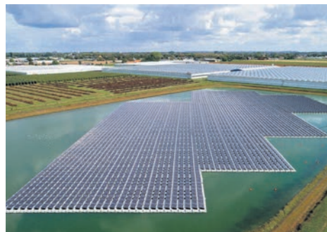
Lingewaard Energie nam het initiatief een drijvend zonnepark aan te leggen waarmee elektriciteit wordt opgewekt.
