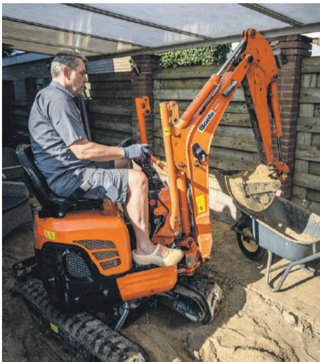
Wim heeft zelf de 5.000 liter tanks ingegraven
